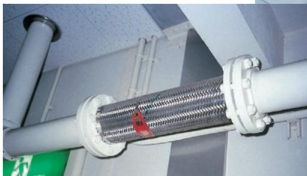
● 溶接なしタイプ Non welded type
